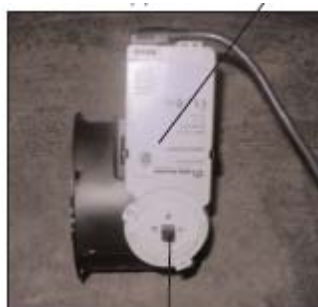
Соединение заслонки с рукояткой (2)
